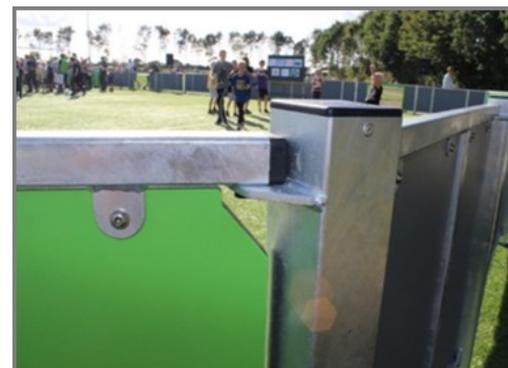
Les panneaux en HDPE sont fixés aux brides soudées de 42,5 x 40 x 3 mm avec des boulons en acier inoxydable M8. Ces jonctions ne sont pas visibles de l'intérieur et créent une connexion solide et sûre.
